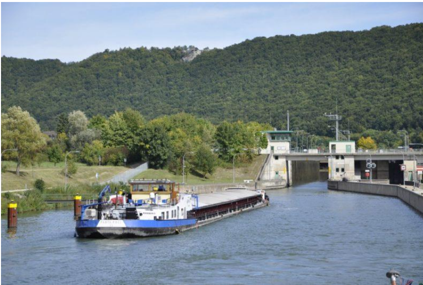
Der Main-Donau-Kanal jubiliert (Bild: RMD Wasserstraßen GmbH, München)
