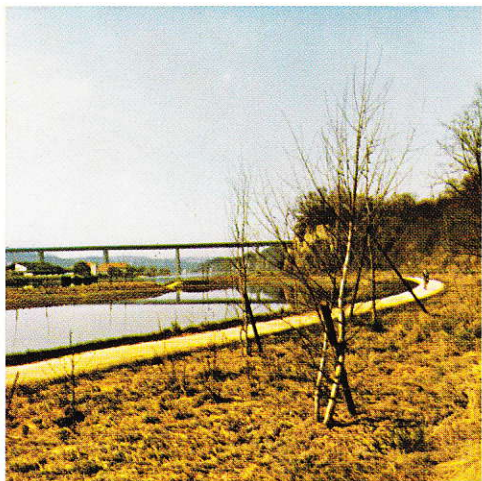
Altwasser mit Autobahnbrücke Nürnberg-Regensburg bei Sinzing
